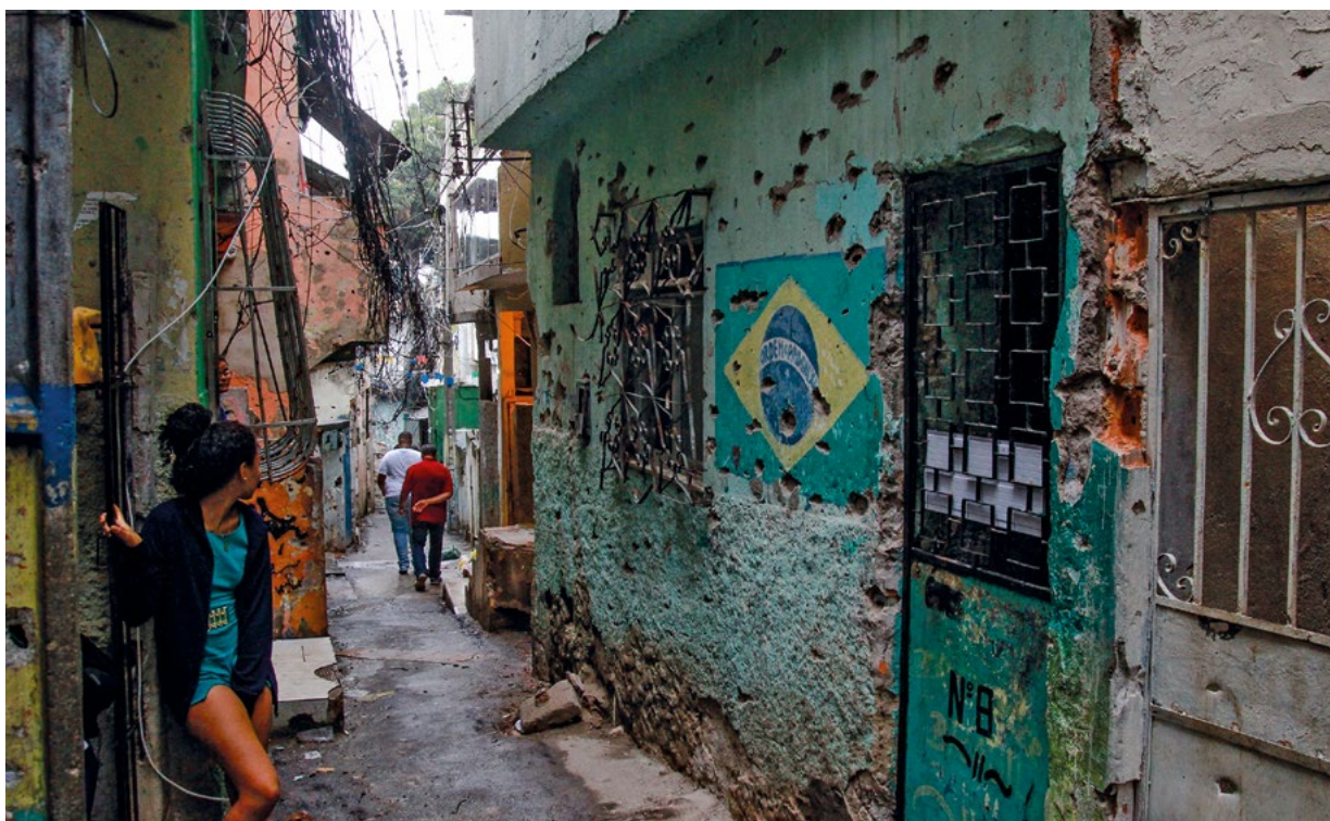
Como uma guerra: parede de uma residência com muitos buracos de bala durante operação policial no Complexo do Alemão, Rio de Janeiro
